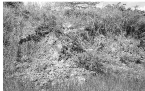
Figura 2. Deslizamiento del talud por desecación de la arcilla lutita (Ordóñez J. 2016)
